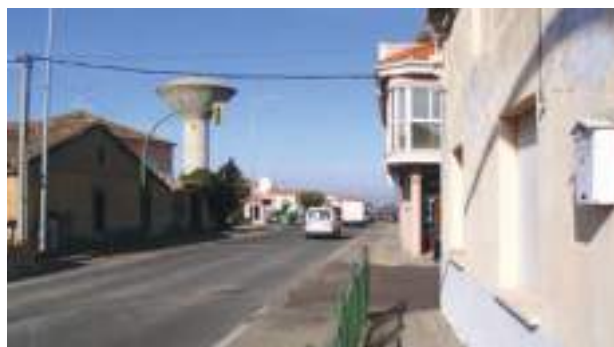
TRAVESÍA CON VISTAS A MARGEN DERECHA DEL NÚCLEO
