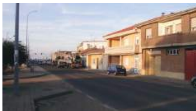
TRAVESÍA CON VISTAS A FRENTE DEL MARGEN IZQUIERDO DEL NÚCLEO
